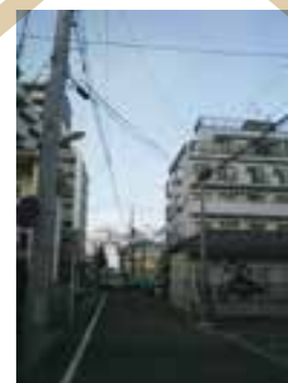
通学路で多く見かけた電線。災害時に電線が切れて垂れ下がり、子どもが接触しないか不安。
